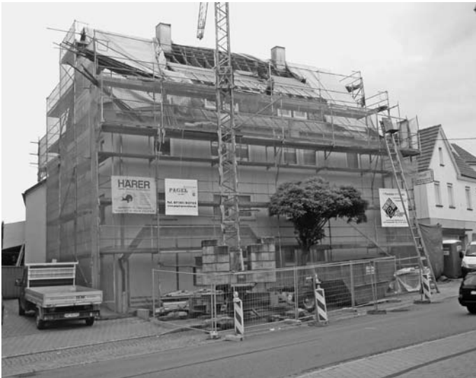
Die Renovierungsarbeiten für das gemeindeeigene Mehrfamilienhaus Hauptstraße 27 beginnen. Das Gebäude bekommt u.a. eine moderne Heizung und wird wärmeisoliert. Damit geht die Gemeinde mit gutem Beispiel voran, die gerade in diesem Teilbereich des Ortes schlechte Luftqualität zu verbessern.
