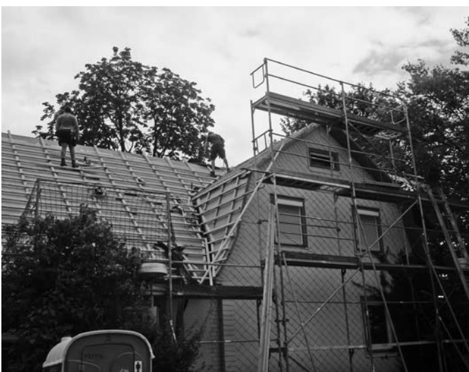
Auch das „Kinderschule“ erhält ein neues Dach.
