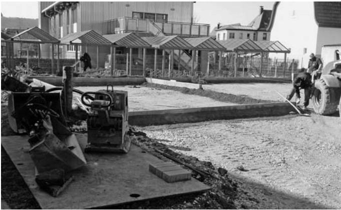
An der Wittumschule werden am Standort des ehemaligen und inzwischen abgebrochenen Lehrerwohnhauses zusätzlich neue Parkplätze gebaut.
