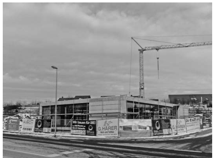
Die Bauarbeiten an weiteren Gewerbeobjekten im Baugebiet Mühlwiesen schreiten voran.
