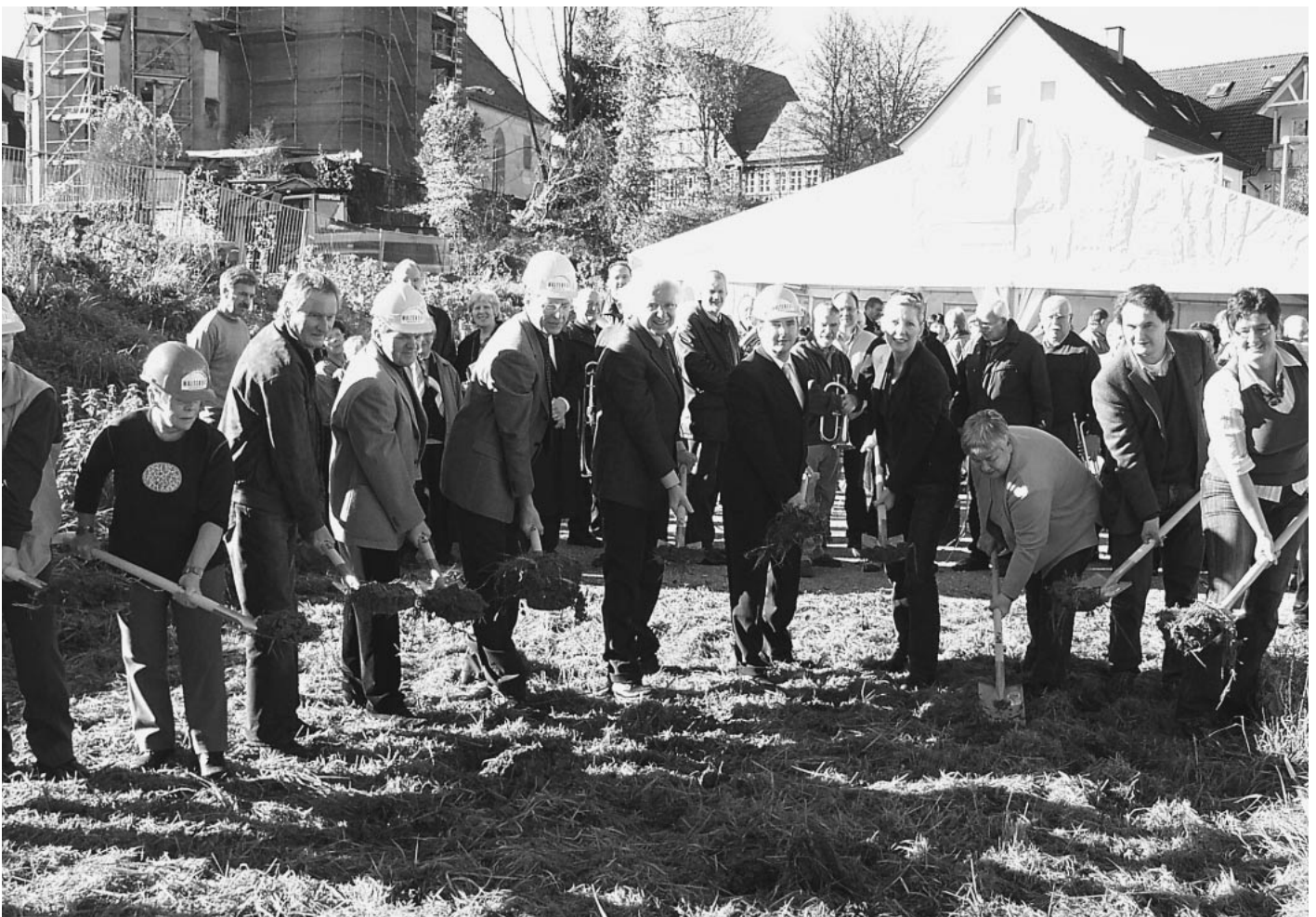
An der Ecke Mühlstraße/Beckengasse machen Vertreter des Investors FWD-Wohnbau und der Gemeinde den ersten Spatenstich zum Bau einer zentrumsnahen Seniorenwohnanlage, die auf der dortigen Baulücke derzeit entsteht.
