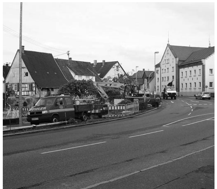
Die Arbeiten zum Bau der Kreisverkehrsplatzes Mühlstraße/ Hauptstraße/ Schorndorfer Straße beginnen. Bis Ende November dauert es, bis diese Großbaustelle fertiggestellt ist.
