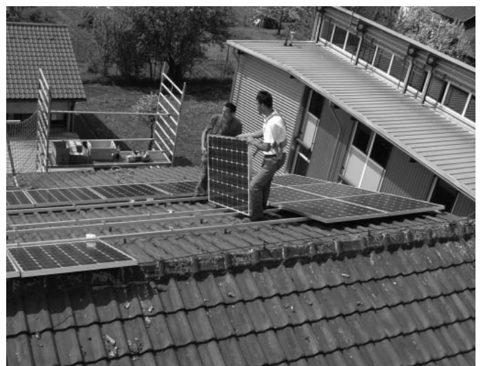
Auf dem Dach der Wittumschule wird nach der Atriumhalle eine weitere größere Fotovoltaikanlage installiert. Diese von Urbacher Bürgern finanzierte Anlage produziert in Spitzenzeiten Strom für 20 Haushalte und sorgt so für eine erkleckliche Reduzierung des CO 2 -Ausstoßes.
