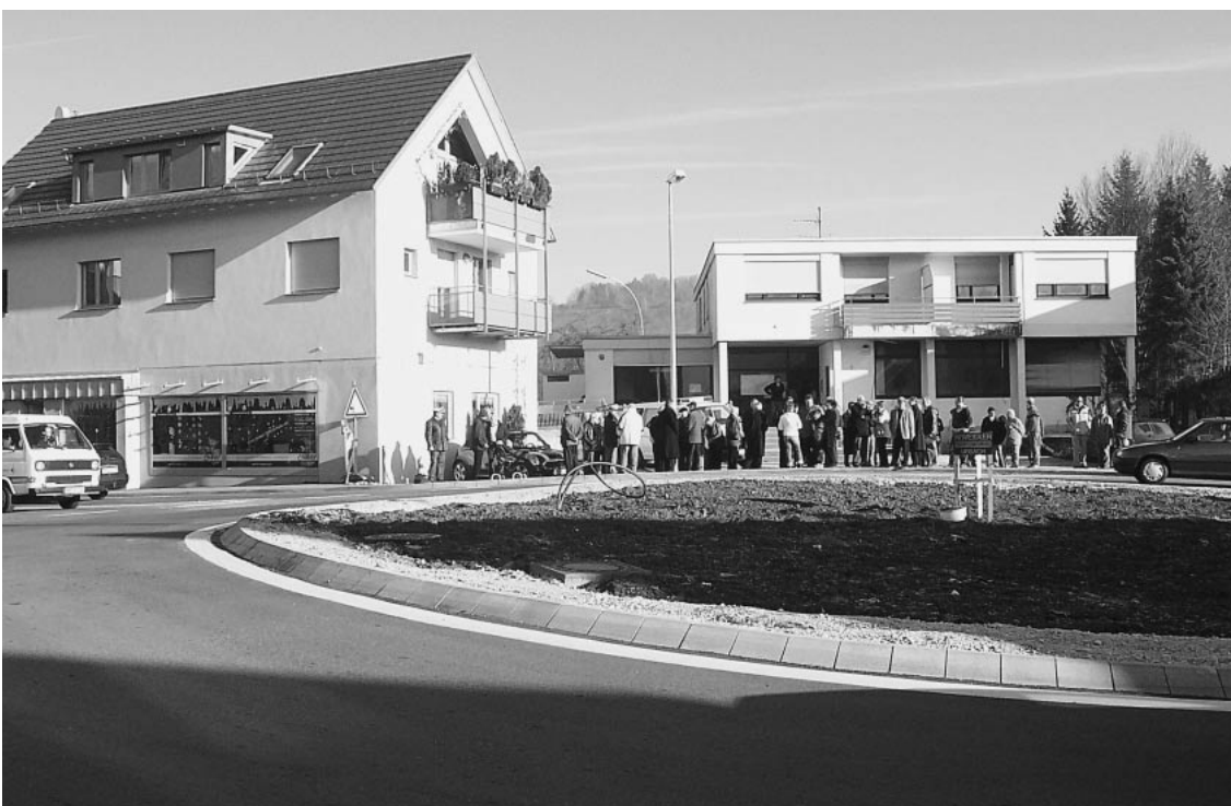
Der Kreisverkehr Mitte – noch etwas schmucklos – wird nach fünfmonatiger Bauzeit offiziell seiner Bestimmung übergeben. Im kommenden Jahr wird er im Zusammenhang mit der Neubebauung der Urbacher Mitte ansprechend gestaltet.
