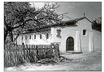
Die Notkirche in der Steinfeldstraße in Urbach
