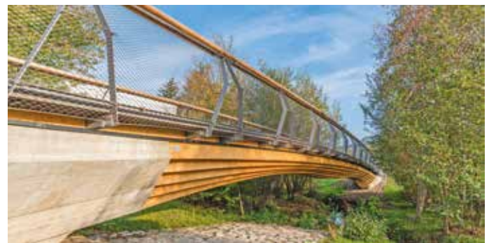
Die so genannte „Stuttgarter Holzbrücke“ über den Urbach, die die beiden Bau- bzw. Wohngebiete „Mitte I“ und „Mitte II“ miteinander verbindet, wird mit dem Staatspreis Baukultur in der Kategorie „Infrastruktur/Ingenieurbau“ ausgezeichnet.
