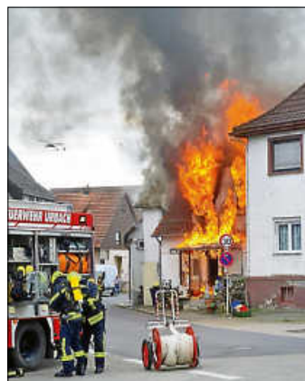
Beim Eintreffen der Feuerwehr stand das Gebäude in der Haubersbronner Straße bereits im Vollbrand.
