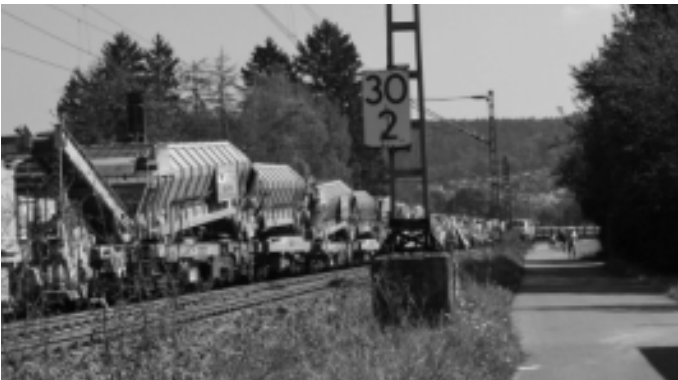
In Urbach fährt bis Mitte Oktober kein Zug mehr – die Remsbahn wird saniert. Nicht nur die in die Jahre gekommenen Gleise und Schwellen werden ausgetauscht, sondern auch Oberleitung und Bahndämme erneuert. Die Berufspendler und sonstigen Bahnkunden werden derweil mit Bussen nach Schorndorf gebracht.
