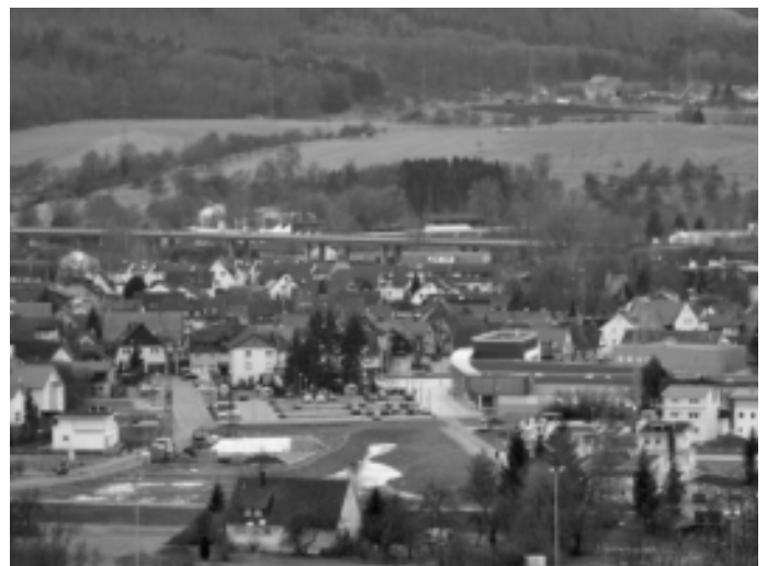
Die Bautätigkeit in der Urbacher Mitte ist ungebrochen. Nach der Fertigstellung des Marktplatzes und der Einkaufsmärkte im Herbst letzten Jahres geht es auch mit der Wohnbebauung voran. Im kommenden Frühjahr werden die Grünbereiche und Spielplätze angelegt.
