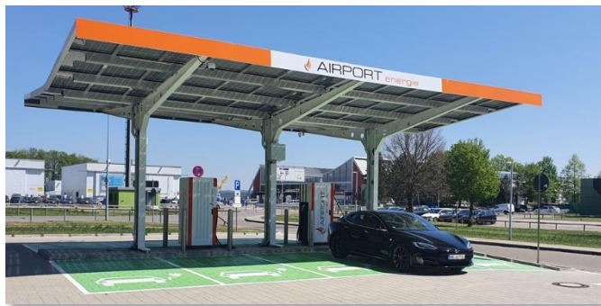
Energiezentrale Biogas Allgäu Airport nach Ausbau
