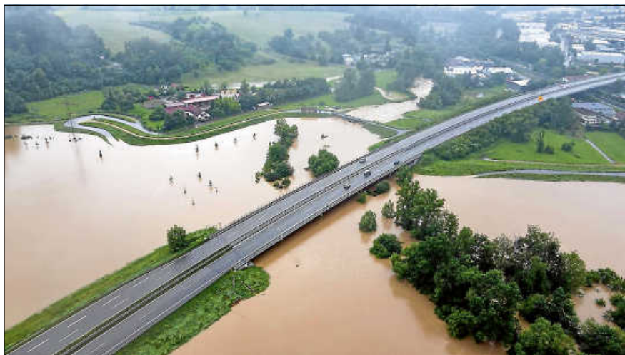
Das erstmals voll eingestaute Hochwasserrückhaltebecken zwischen Urbach und Plüderhausen hat Urbach und die Rems abwärts gelegenen Kommunen vor noch Schlimmerem bewahrt. Foto: Tobias Neubauer (FFW Plüderhausen)
