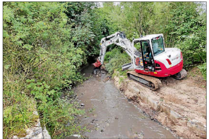
Entfernung von Anlandungen des Urbachs am Skatepark/Friedhofsstraße
