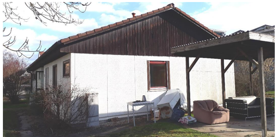
Foto 1: Außenfassaden und holzverschalter Südgiebel von Gebäude Nr. 33
