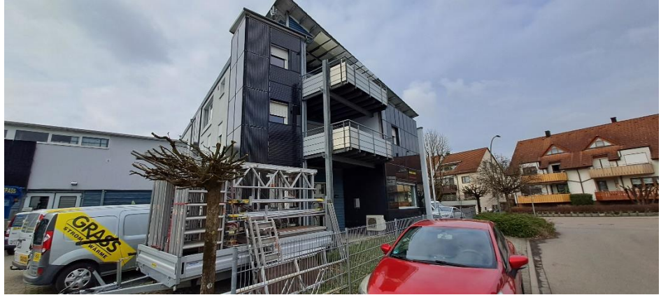
Foto 8: Ostfassade des Gebäudes Neumühleweg 27
