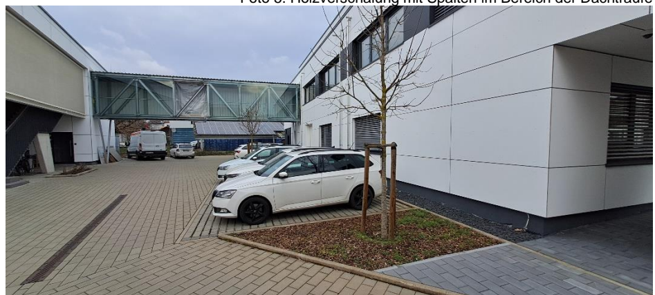
Foto 6: Gepflasterte Flächen zwischen den Gebäuden Raiffeisenstraße 17 und 19
