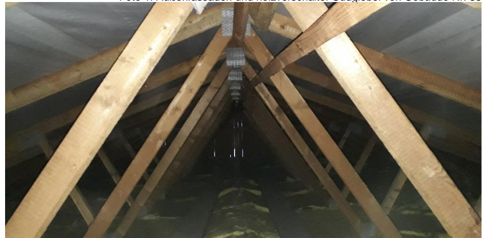
Foto 2: Dachstuhl mit holzverkleidetem Südgiebel von Gebäude Nr. 33
