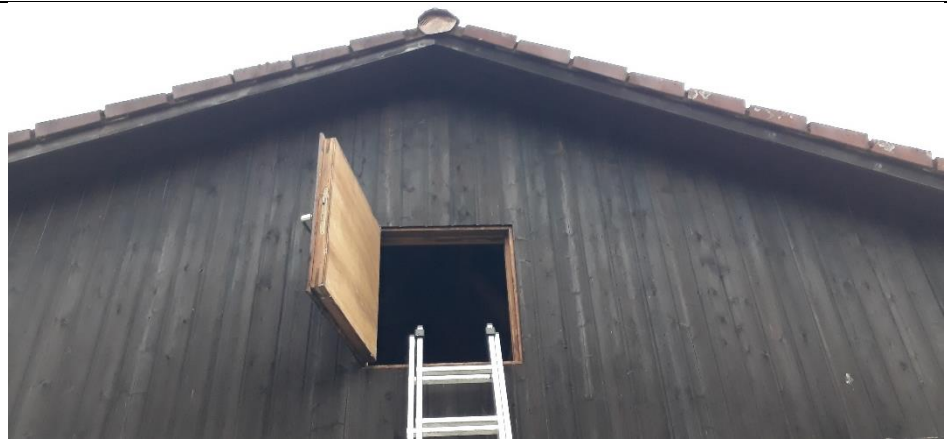
Foto 3: Holzverschalter Giebel mit Wartungsfenster (Nordgiebel von Gebäude Nr. 31)
