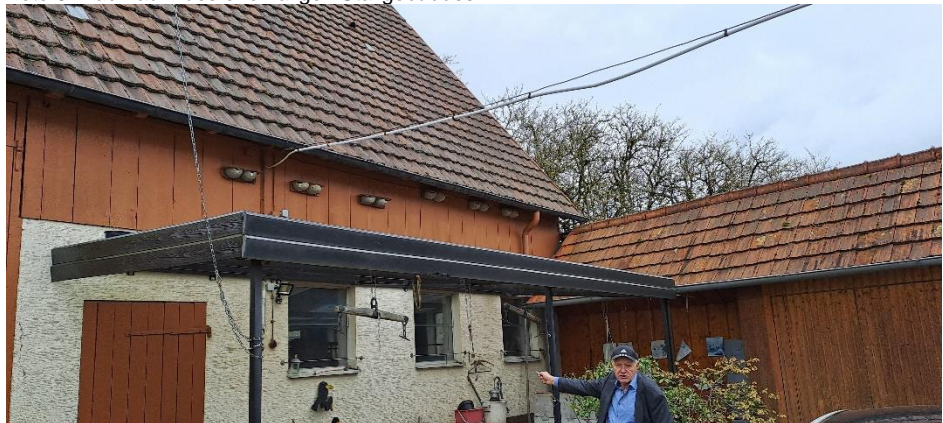
Foto 7: Westfassade des ehemaligen Stallgebäudes mit Mehlschwalben-Nisthilfen
