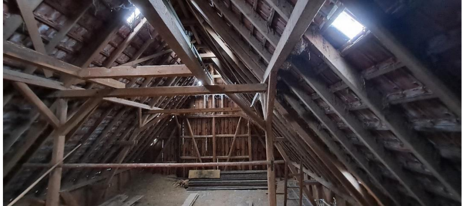
Foto 6: Dachraum des ehemaligen Stallgebäudes
