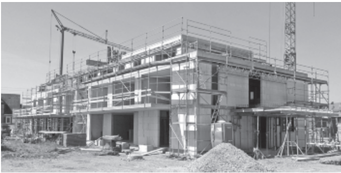
Baustelle Kita Wiese im Juni 2014
